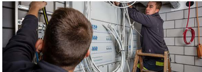
Installationsanzeige Umbau/Ersatzneubau/Teilabbruch und Abbruch Neuen Antrag stellen...
